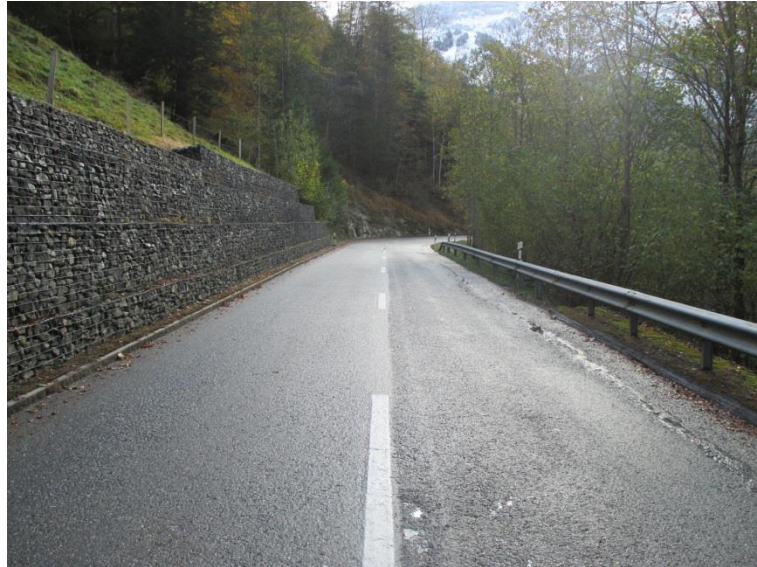
Strasse mit talseitig leichten Senkungen Die talseitige Steinkorbmauer wurde 1992 erstellt Hinter der Mauer zeigen sich die leichten Senkungen
