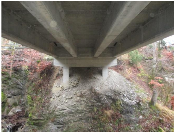
Längsträger und Brückenplatte
