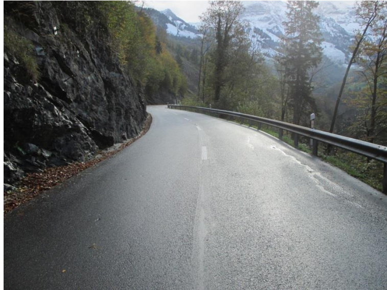
Enge Strasse mit Rückhaltesystem, talseitig mit steiler Böschung
